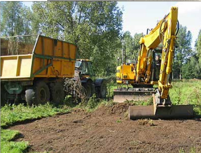
Afgeplagde berm en het gebruik van kraan met platte bak
